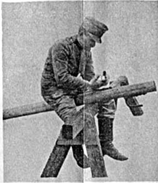
Fig. 5. Aufschrauben des Isolators.
