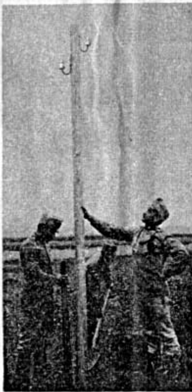
Setzen der Stangen.
