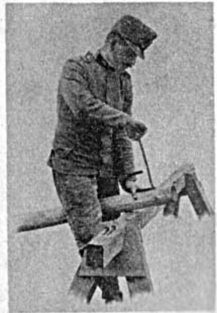
Fig. 7. Säulensetzen.
