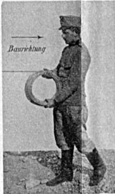
Fig. 8. Abwickeln des 3 mm Drahtes.
