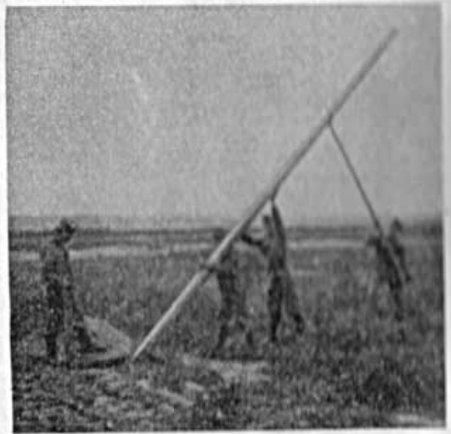
Fig. 7. Säulensetzen.
