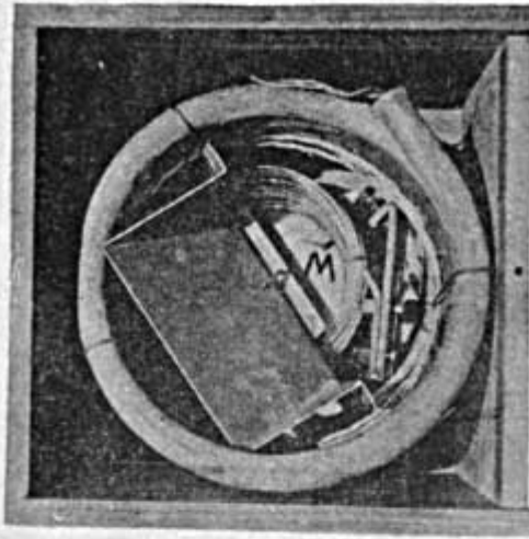
Fig. 6. Kiste mit Stationseinführung u. Erdleitung.
